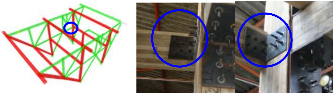
Figura 20: Conexión no resistente a momento C1-T6
