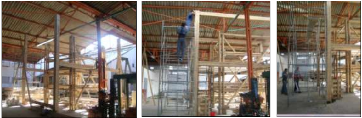
Figura 30: Montaje de Prueba de carga
